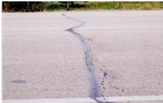
Thermal Cracking
