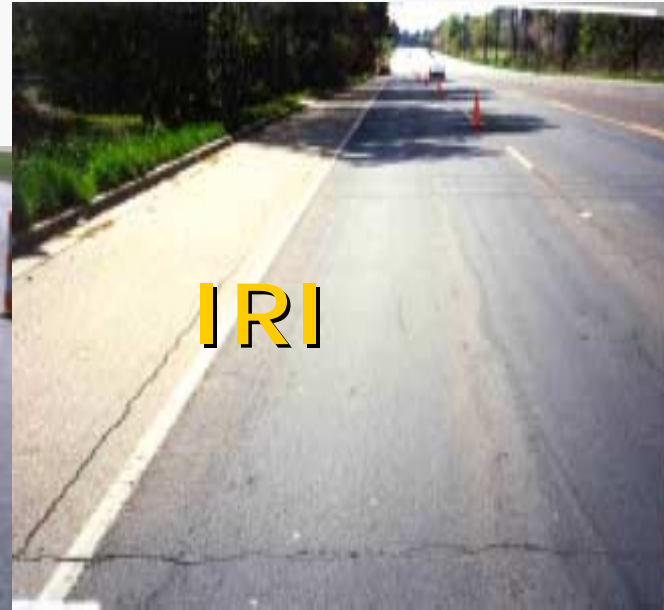
Longitudinal Cracking
